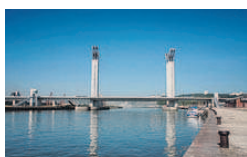
Rouen, Francia. Un puente elevador que iza sus carriles al paso de los barcos.
