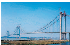
Taizhou, China. Cuenta con dos vanos de más de un kilómetro de largo cada uno.
