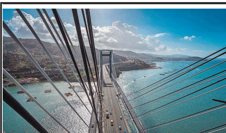
Ingenieros de cien países han premiado la ampliación del puente, considerado el segundo mejor del planeta después del nuevo de Liverpool.
