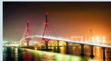
● Puente de la Constitución de 1812 (Cádiz). Conocido como el puente de «La Pepa», es el acceso a la ciudad de Cádiz desde el continente, en el término de Puerto Real.
