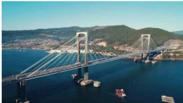
El puente de Rande tras las obras de ampliación / Ministerio de Fomento
