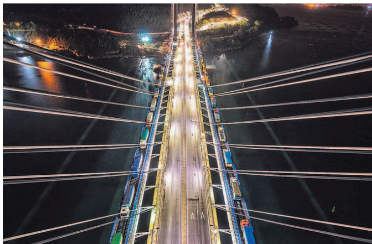
70 camiones sobre Rande. Así se veía desde lo alto la prueba de carga hecha en el puente el 26 de diciembre del 2017. MC2 ESTUDIO DE INGENIERÍA
