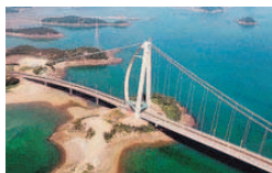
Dandeung, Corea del Sur. Premiado por el diseño de su pilar en forma de D de 105 metros.
