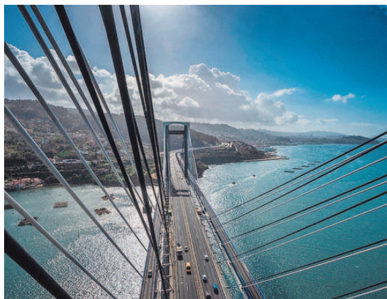
Vista de cómo ha quedado el puente de Rande desde su cima, situada a 152 metros de altura.
