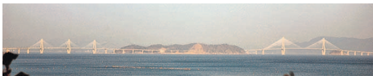
Busan, Corea del Sur. Combina desde el 2012 sus dos puentes atrirantados con un túnel bajo el mar de 3,5 kilómetros de longitud.
