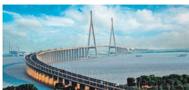
Sutong, China. Tiene 8,2 kilómetros de largo y un vano de 1.088 metros.
